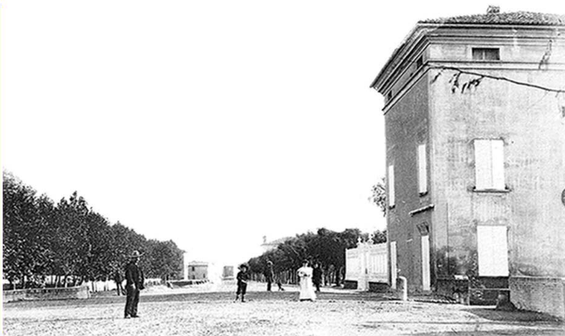
Figura 1 – Palazzo Remondini - fotografia storica ante 1911.
