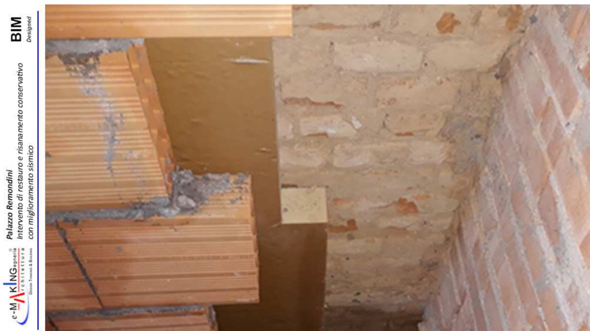
Figura 18 – Murature perimetrali provviste di controperete interna
